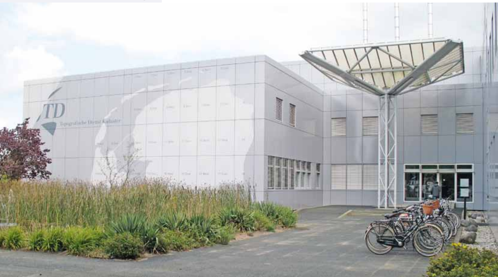
1. Het gebouw van de Topografische Dienst in Emmen
